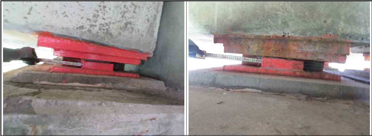
교량받침 이동량 측정
